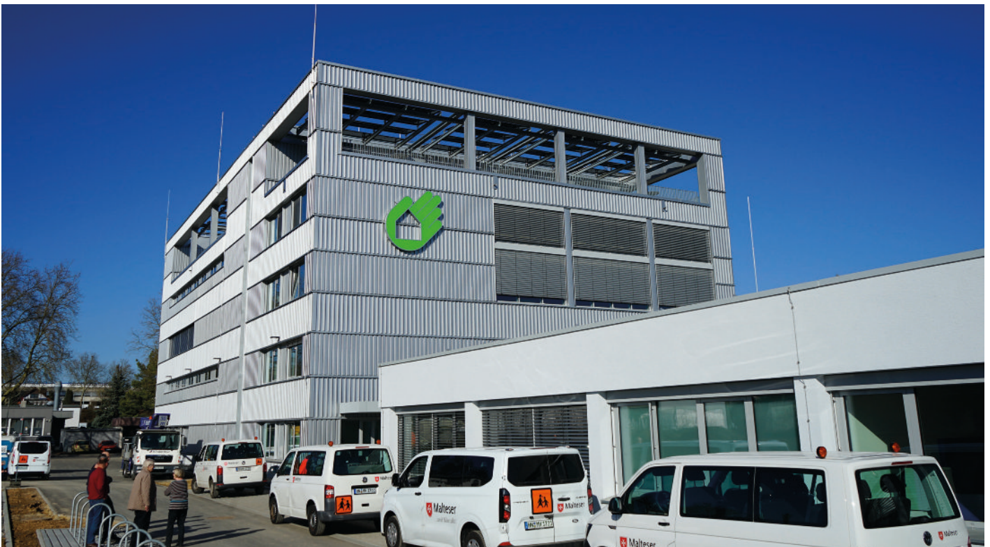
Neue Werkstatt der LebensWerkstatt im Gewerbegebiet Haselter in Böckingen.
